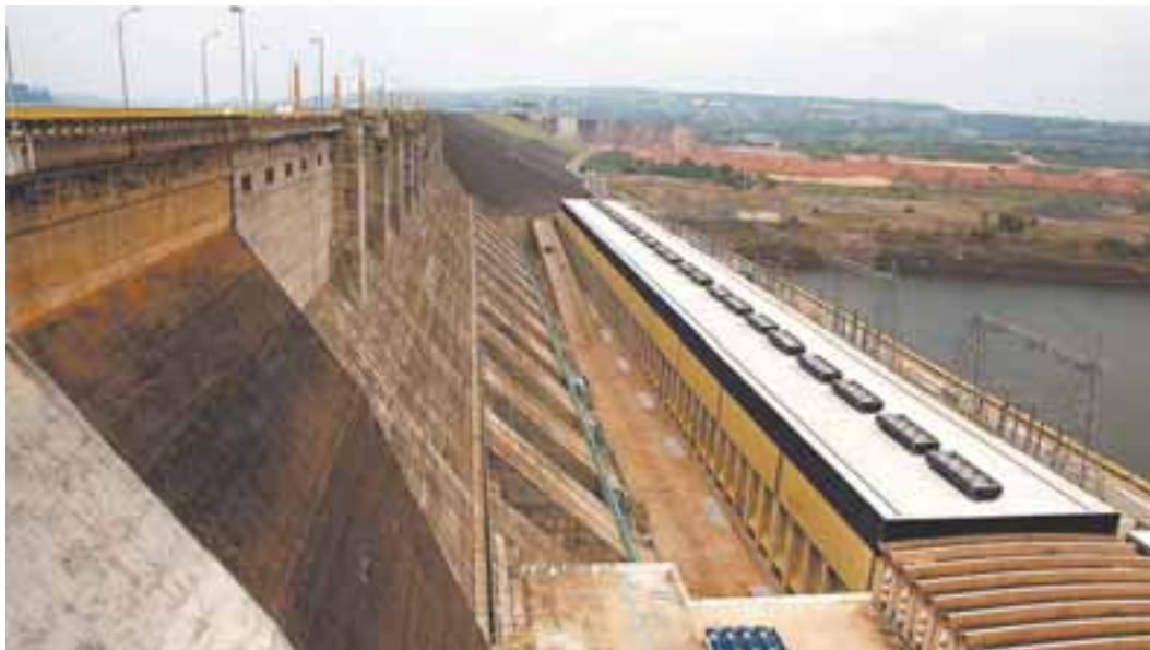
Aspecto da usina hidrelétrica de Tucuruí, quando da ampliação de sua segunda turbina: uso de tecnologia de ponta aplicada em plataformas
